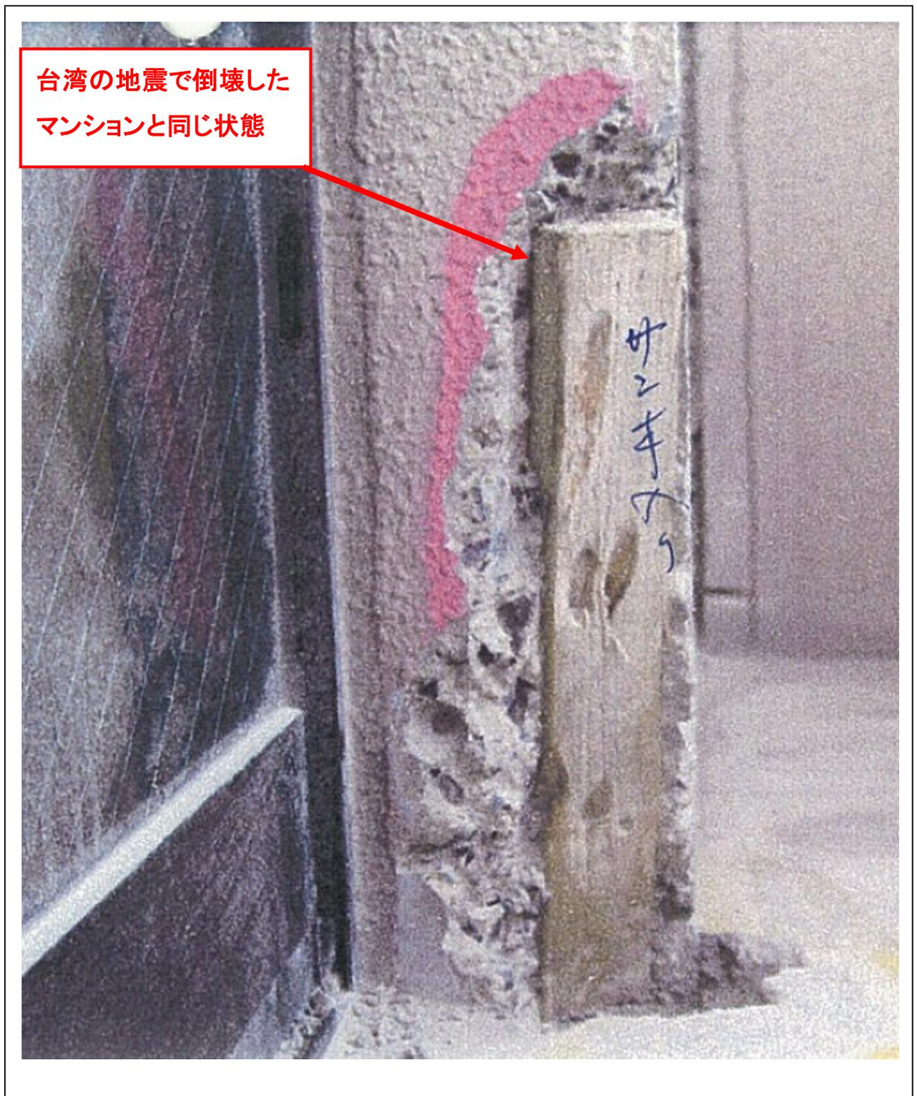
下記の写真は、久留米の新生マンション花畑西で、鹿島建設の施工不良の一つで、鉄筋の被り厚さが確保されていなかった事が原因で鉄筋が爆裂しコンクリートが落下した箇所の写真です。落下した際に、住民に被害がなかった事が不幸中の幸いでした。
